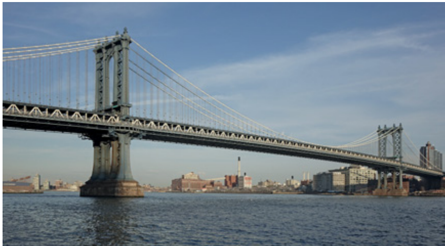
Fig. 6. Escala geográfica del Puente de Manhattan, de 2000 m de longitud y 450 m de vano (Modjeski & Moisseiff, 1909).
