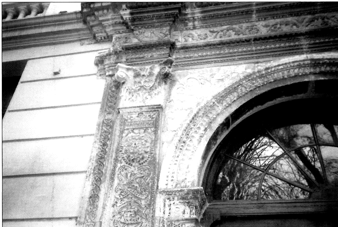
Fig. 15. Palacio de don Antonio de Mendoza en Guadalajara. Fachada principal. Detalle del capitel y entablamento.
