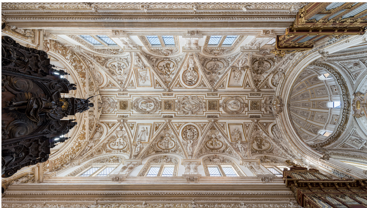
Fig. 5. Bóveda del coro. Catedral de Córdoba. Juan de Ochoa (arquitecto) y Francisco Gutiérrez Garrido (escultor). 1598-1602. Fotografía cedida por Xosé Garrido.
