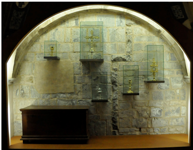
Fig. 12. Moldura quebrada en el muro septentrional del transepto de la catedral de Jaca, actual muro del secretum (foto JMA).
