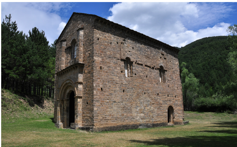
Fig. 10. Santa María de Iguácel vista desde el suroeste (foto JMA).
