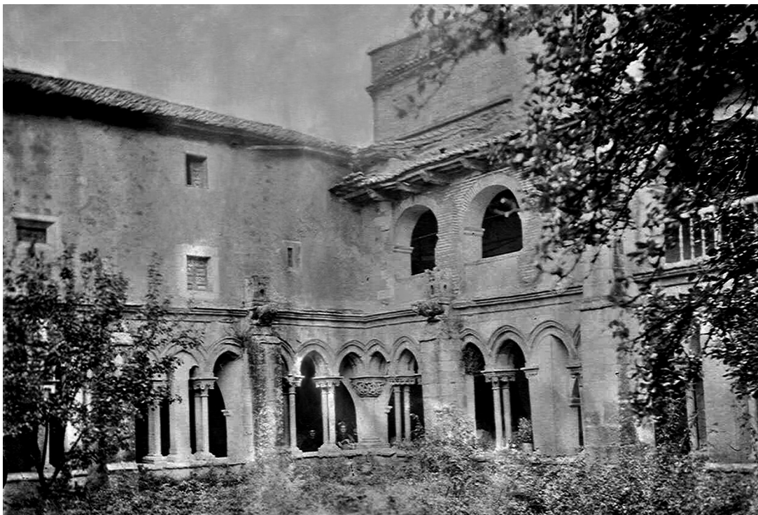
Fig. 2. Claustro de San Andrés de Arroyo (Palencia) antes de la restauración acometida por Anselmo Arenillas. Imagen publicada por Enrique Almaraz (1900).
