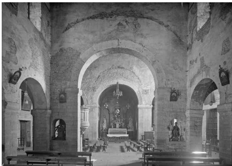
Fig. 9. Santullano. Interior después de la restauración (1932) con los muros desencalados, las huellas de las bóvedas y la armadura restaurada. Bildarchiv. Foto Marburg.
