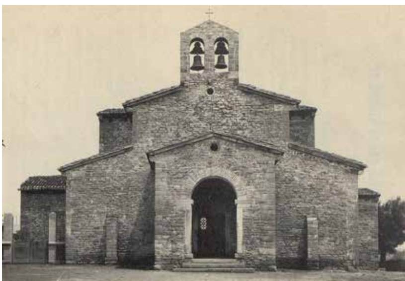
Fig. 7. Santullano. Imafronte después de la restauración. Se han desencalado los muros, se han eliminado el antepórtico y las dependencias laterales del nártex y se ha restaurado la espadaña. Fotografía, publicada por Fortunato de Selgas.
