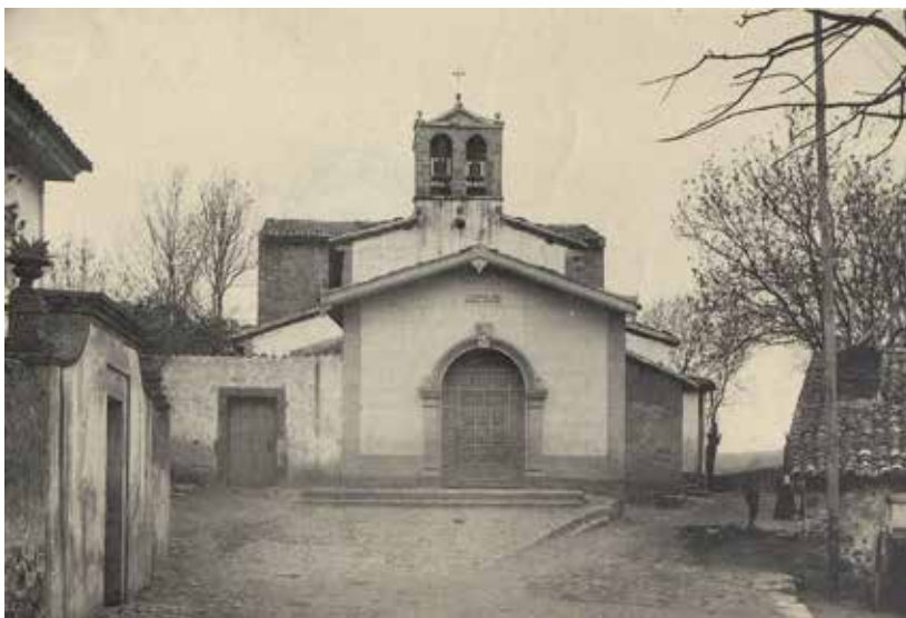
Fig. 6. Santullano. Imafronte antes de la restauración. Se observa en primer término el antepórtico y en segundo plano las dependencias que flanqueaban el pórtico y que hicieron suponer la existencia de un triple nártex. Fotografía, publicada por Fortunato de Selgas.
