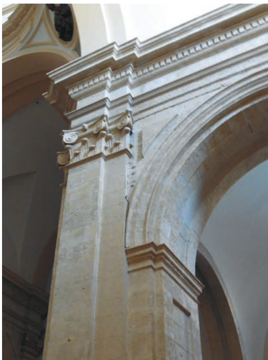
Fig. 6. Pilares de piedra del interior de la iglesia. Fotografía del autor.
