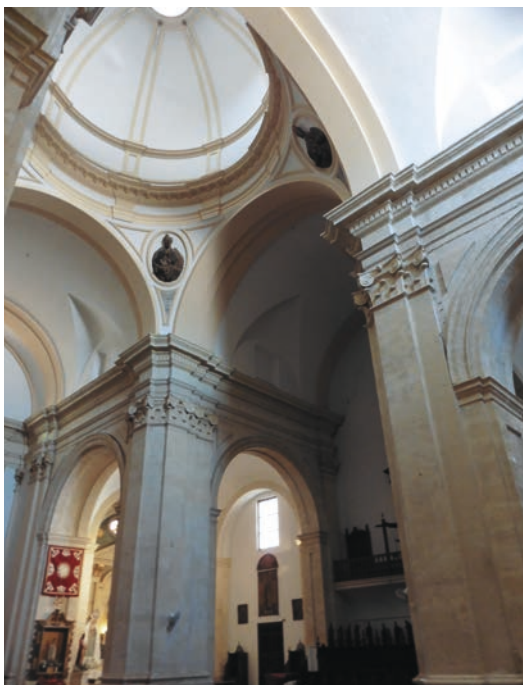
Fig. 9. Interior concluido de la iglesia. Fotografía del autor.
