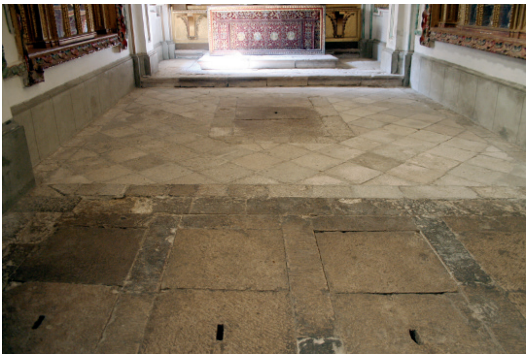
Fig. 7. Enlosado de la capilla relicario en la actualidad.
